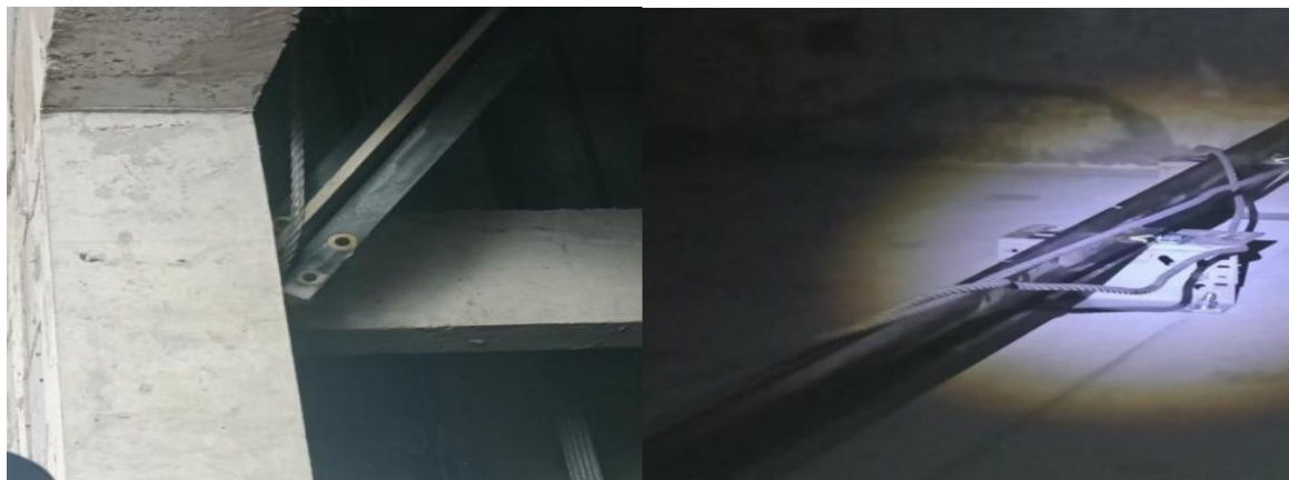
图 8 井道内钢丝绳缠绕情况
